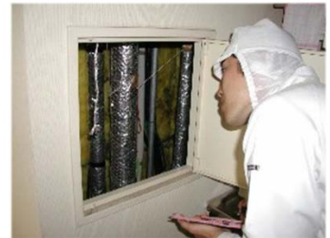
弊社調査員による現場調査
