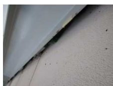
コウモリが生息している隙間
