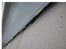
コウモリが生息している隙間
