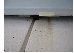
壁の隙間から落とされるコウモリの糞による汚損被害
