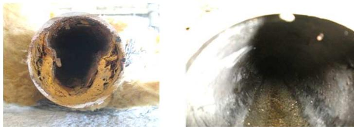
図2.配管洗浄前の排水管（左）と洗浄後の排水管（右）の比較
