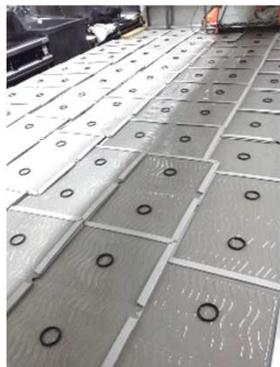
図1.ねずみを捕獲するためのキャッチオール施工
