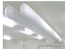
図3 設置した様子
