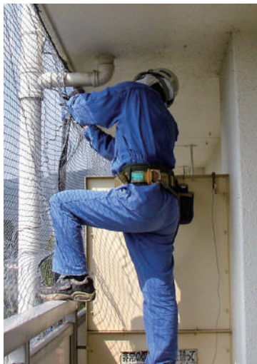
防鳥ネット施工
