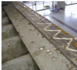
ジェル忌避剤施工
