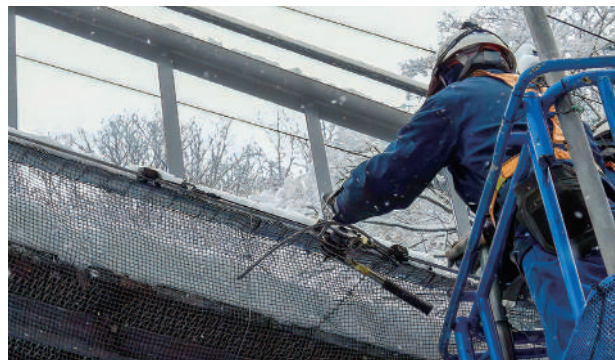
液体忌避剤施工
