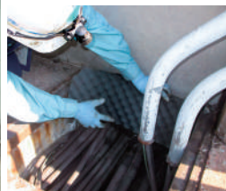
侵入経路の閉塞工事
