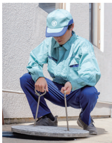
マンホール内の点検・殺虫
